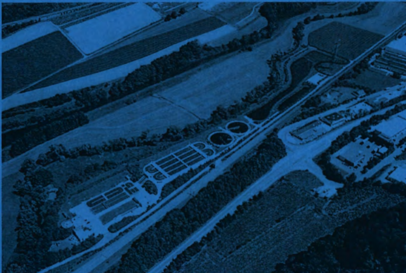
Kläranlage des Ruhrverbandes in Velmede
