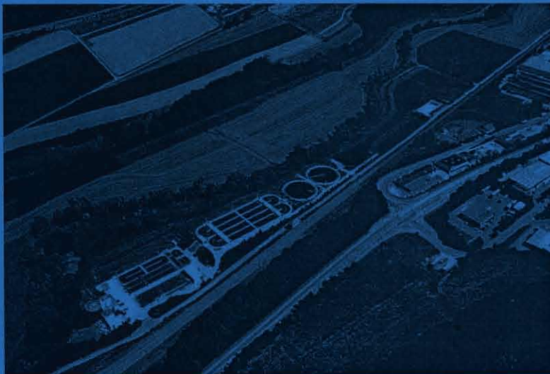
Kläranlage des Ruhrverbandes in Velmede
